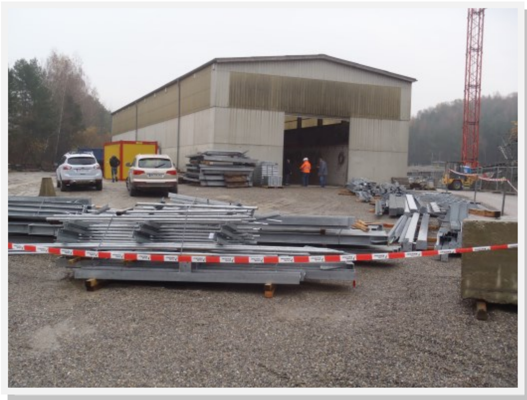
Die ersten Lieferungen des Stahlbaus sind angeliefert.
