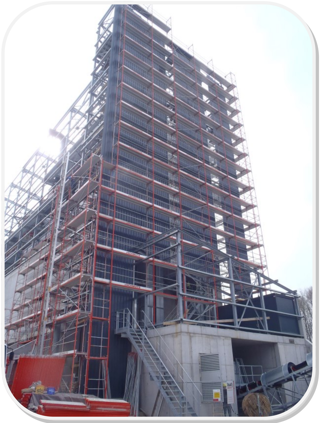
Das Gerüst steht und die Anlage wird eingehaust
