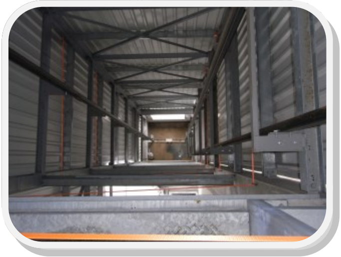
Blick in den Aufzugsschacht.
