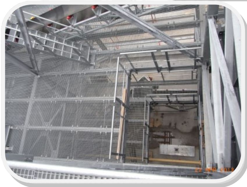
Wartungsschacht auf die einzelnen Bühnen.
