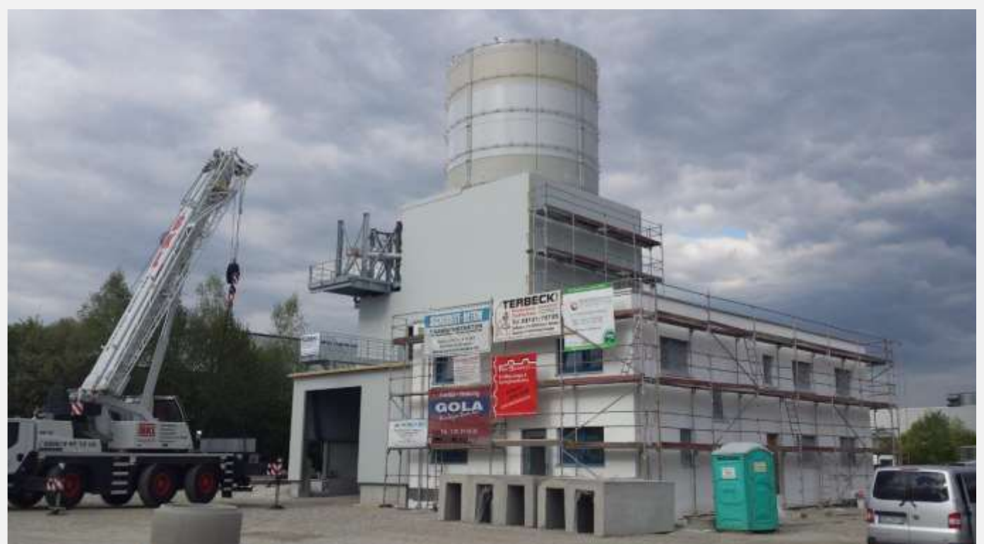
Das Bauwerk wächst.
