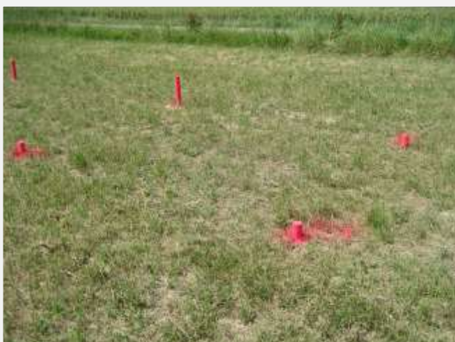
Fundamentabsteckung
