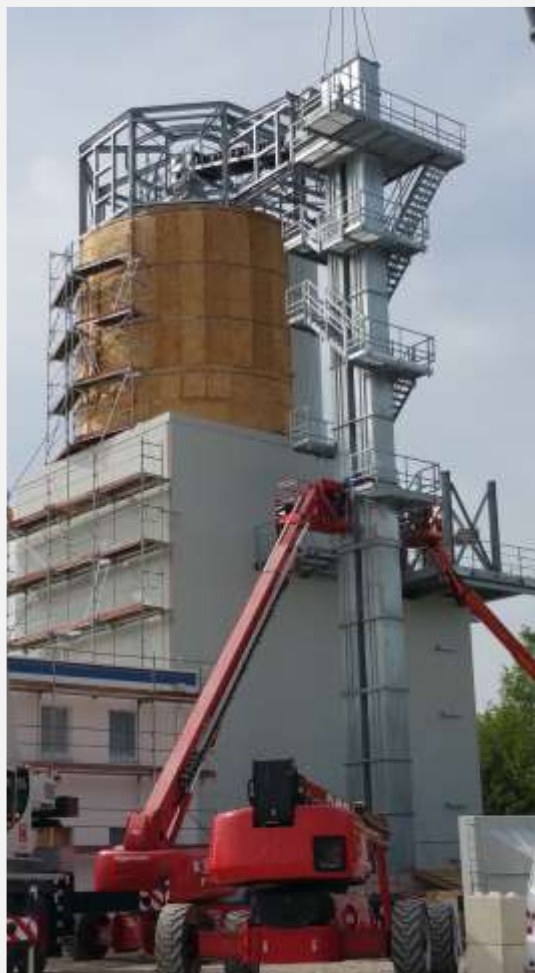
Das Becherwerk wird aufgestellt
