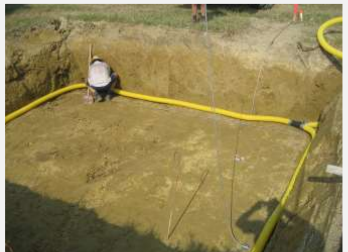
Baugrube mit Ringentwässerung für Schaltheis und Trafo
