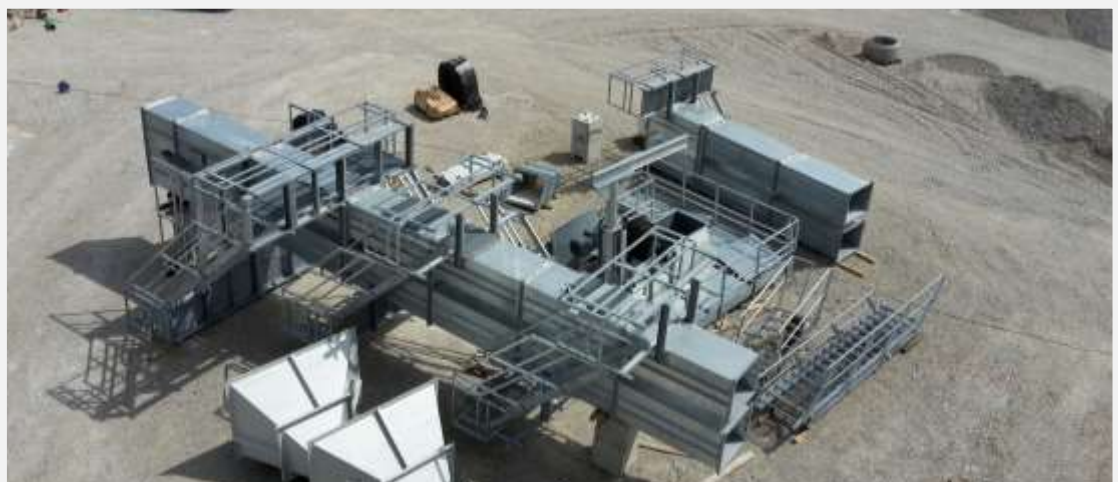
Das Becherwerk liegt zum Einheben bereit.
