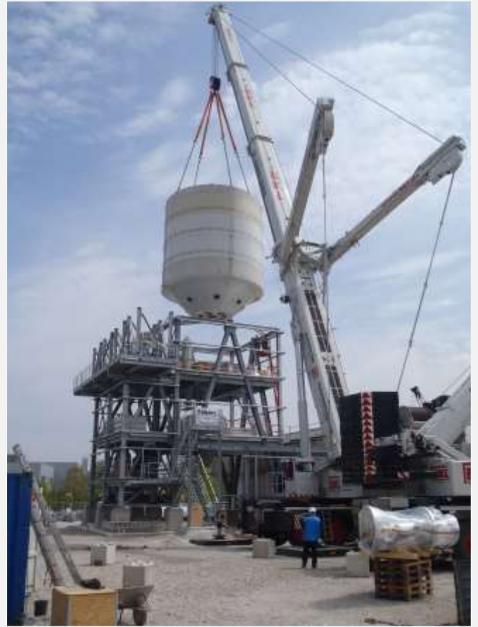
Mehrkammersilo beim Einheben in den Stahlbau
