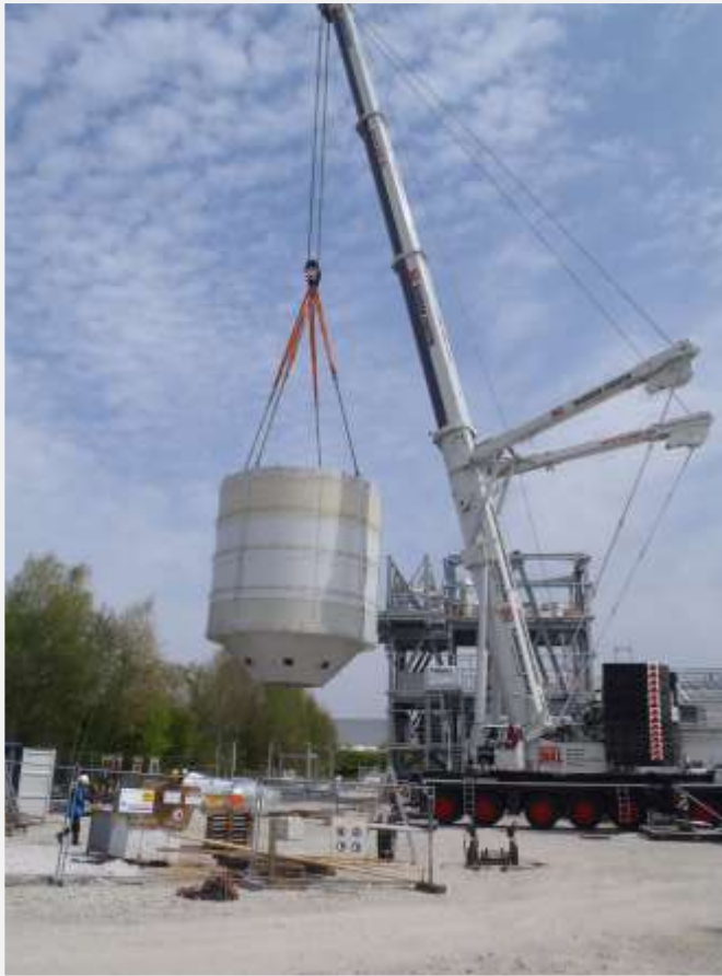
Mehrkammersilo beim Einheben in den Stahlbau
