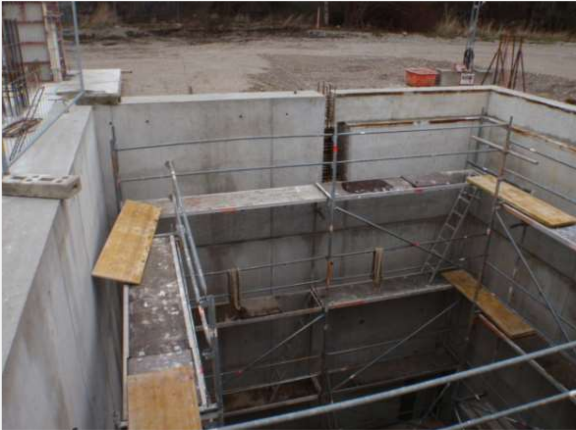
Betonbau für Aufgabetrichter
