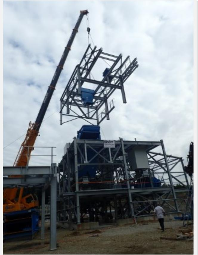
Der vormontierte Stahlbau wird eingehoben.
