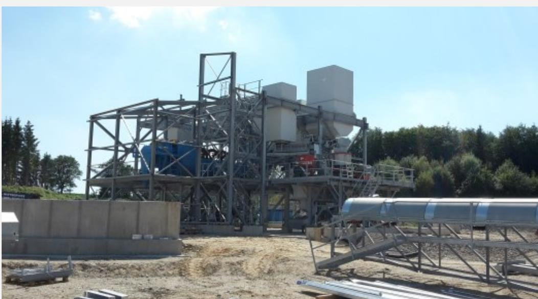
Die Bänder wurden vormontiert und im Zuge der Montage mit eingehoben.
