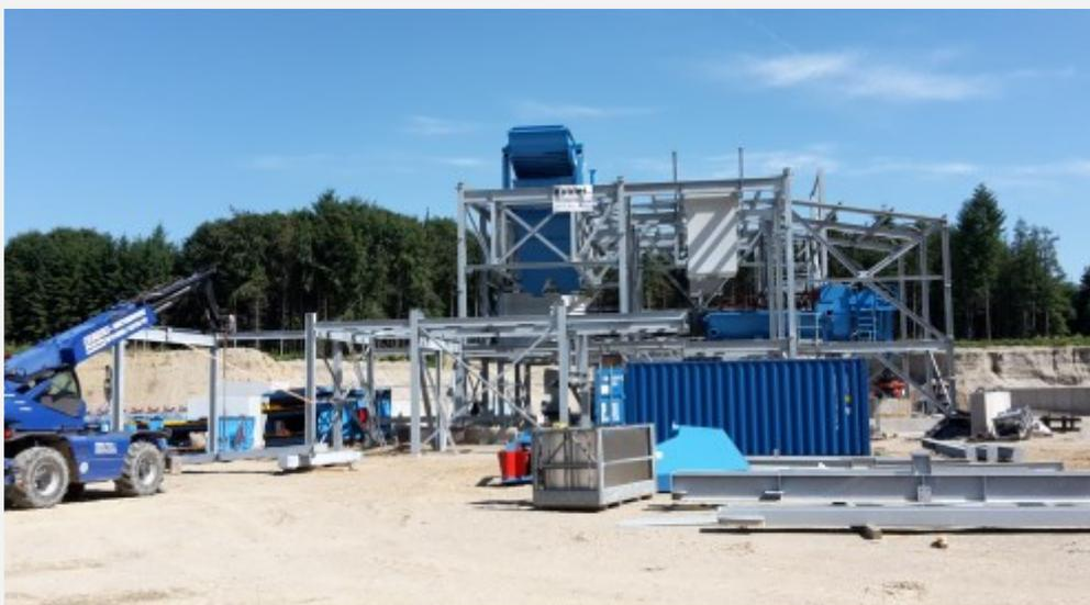
Das Stahlbau nimmt Gestalt an, weitere Puffersilos wurden eingehoben.
