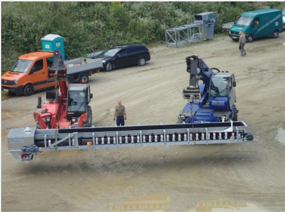
Förderband wird zum Einheben vorbereitet.
