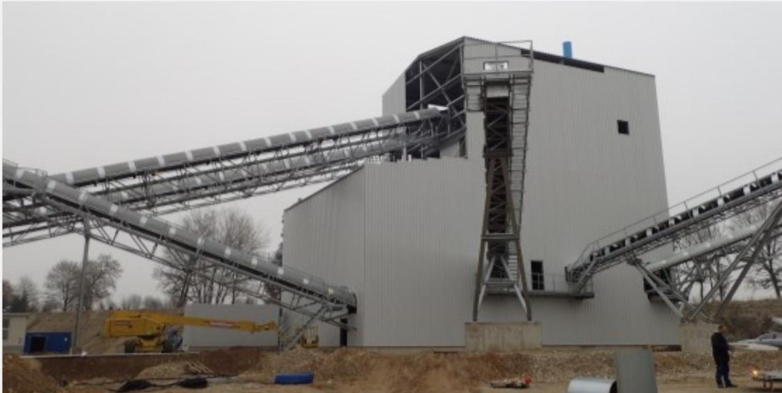
Der Stahlbau für die Trichterüberdachung und Vorsiebstation ist montiert.
