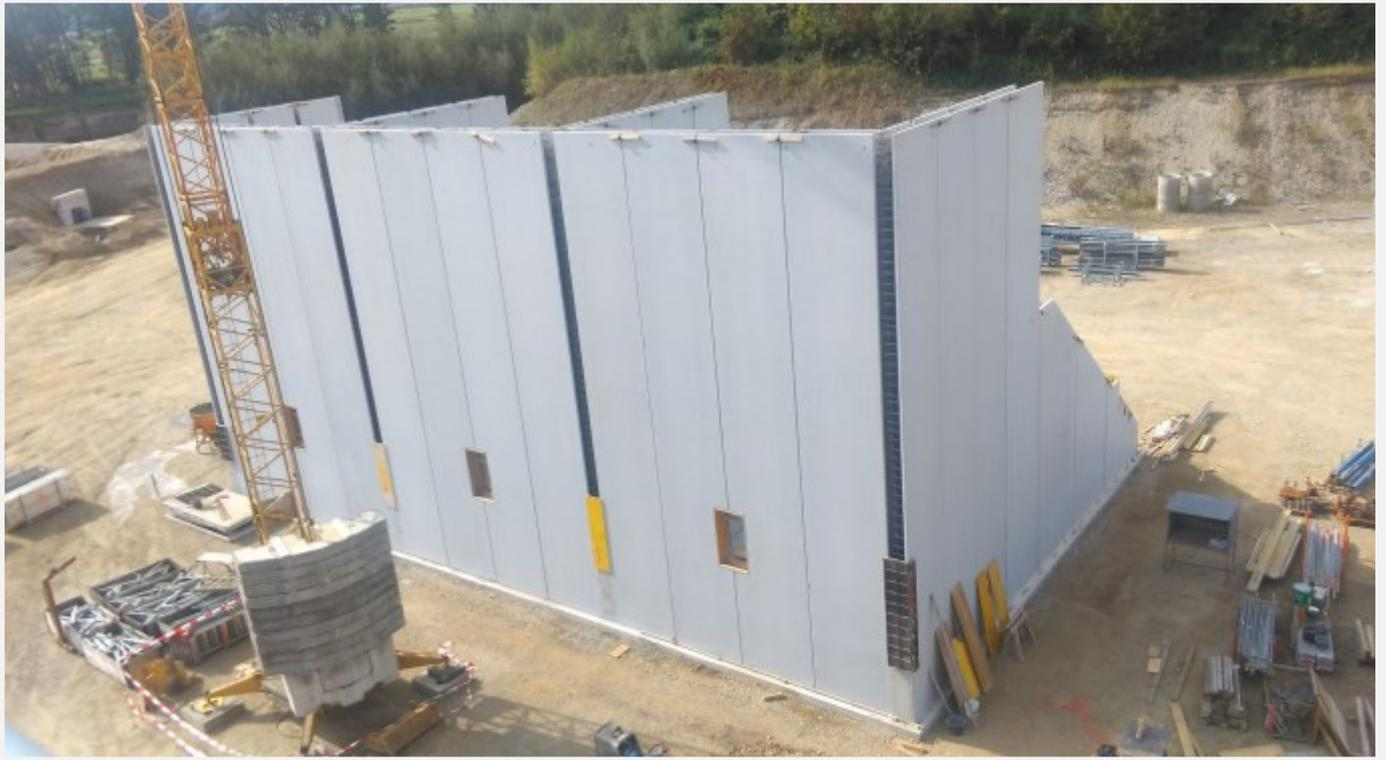
Die Vorsiebstation mit den Förderbändern zur Siebanlage steht und die vormontierten Dachrahmen sind eingehoben.
