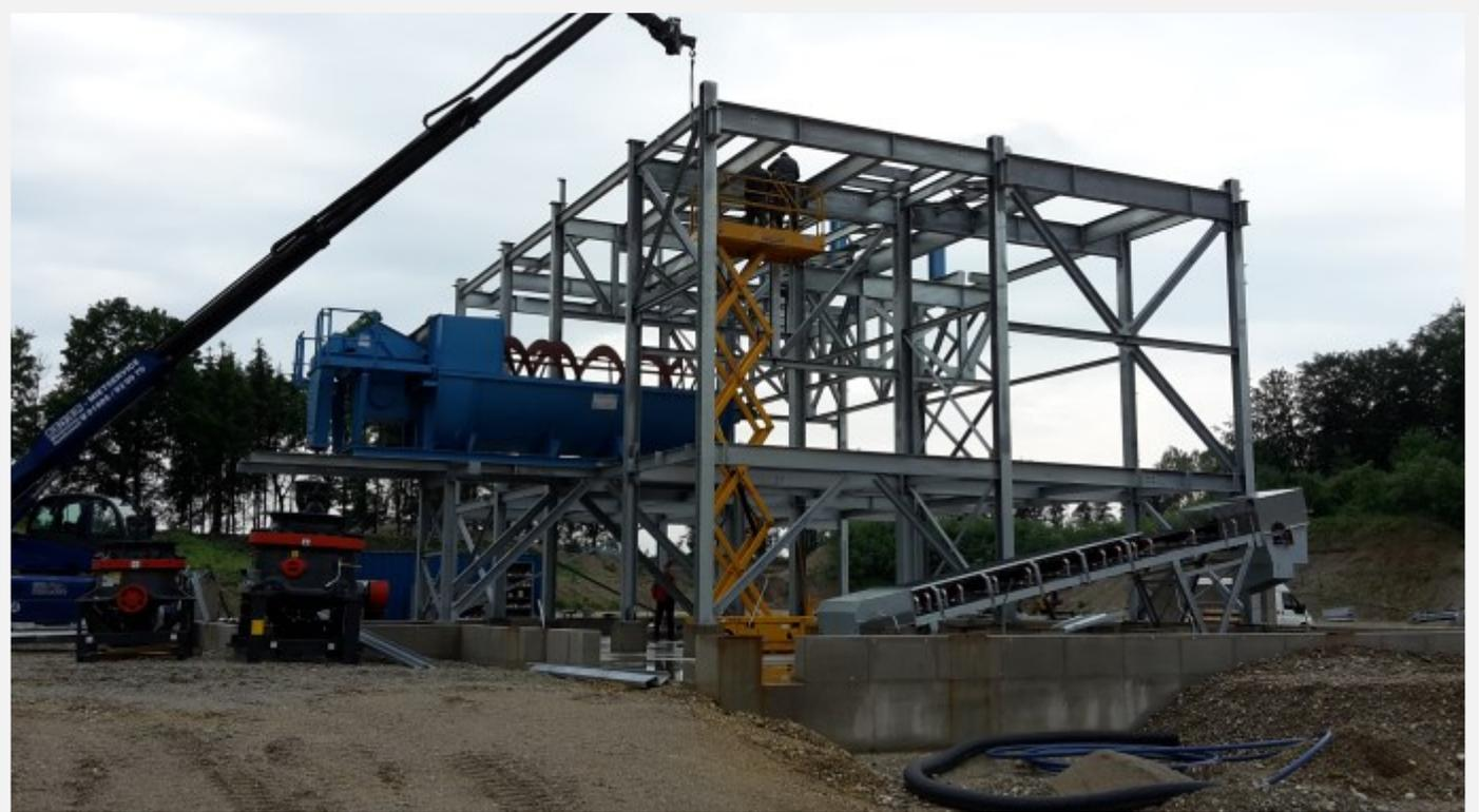
Der Sandfang wurde in den Stahlbau eingehoben.
